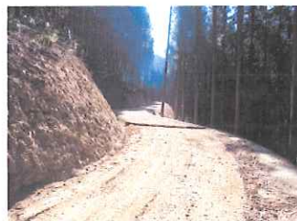
図-6 完成した基幹作業道
