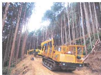
図-5 作業道開設状況
