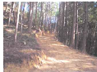
図-7 完成した森林管理路
